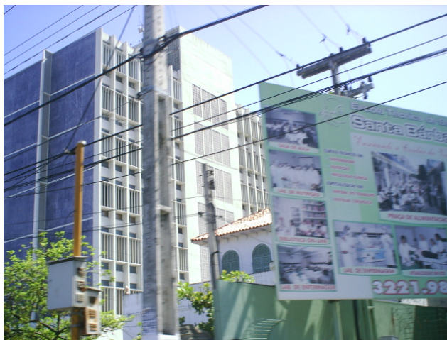
Ilustração 11 - Foto da fachada da Casa da Indústria, Maceió/AL. Fonte: O autor (2006).
