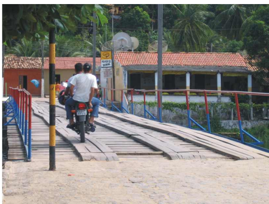
Foto 5 - Ponte sobre a lagoa Jequiá, circulação de veículos de pequeno a médio porte.
