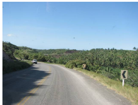
Foto 14 - Trecho da AL-101-Sul, próximo ao acesso do povoado Lagoa Azeda. Fonte: Oliveira, Moisés C. de (2006).
