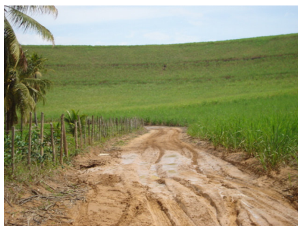
Foto 49 - Trecho da AL-420, após um dia de chuva, próximo à localidade Jequiázinho.
