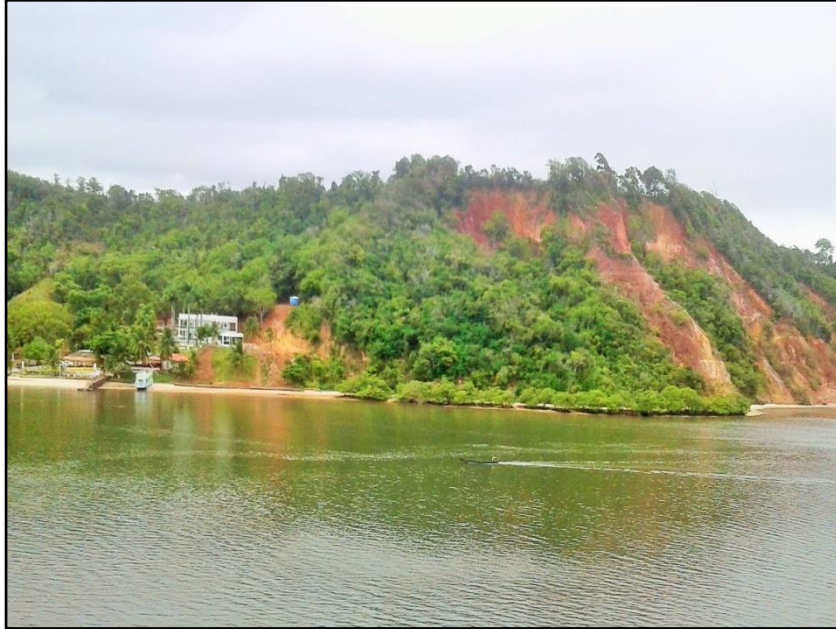
Figura 29 –Vista de área suscetível a deslizamento de massa, Barra de São Miguel
