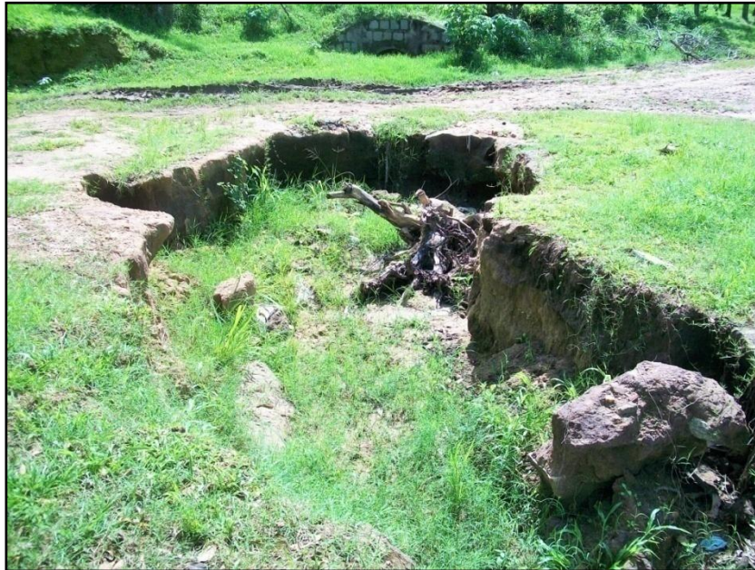
Figura 16 - Erosão nas margens de um afluente do rio São Miguel.
