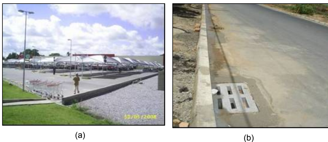
Figura 10 – (a)Edificações comerciais e (b) Vias pavimentadas
