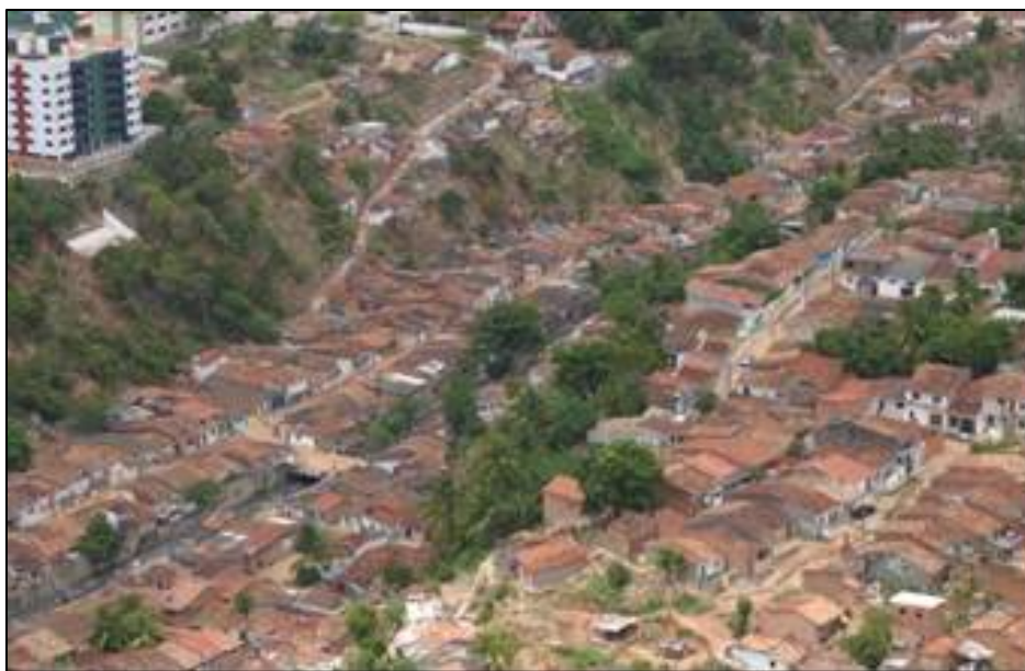
Figura 36 – Vista de parte do Vale do Reginaldo e suas ocupações indevidas
