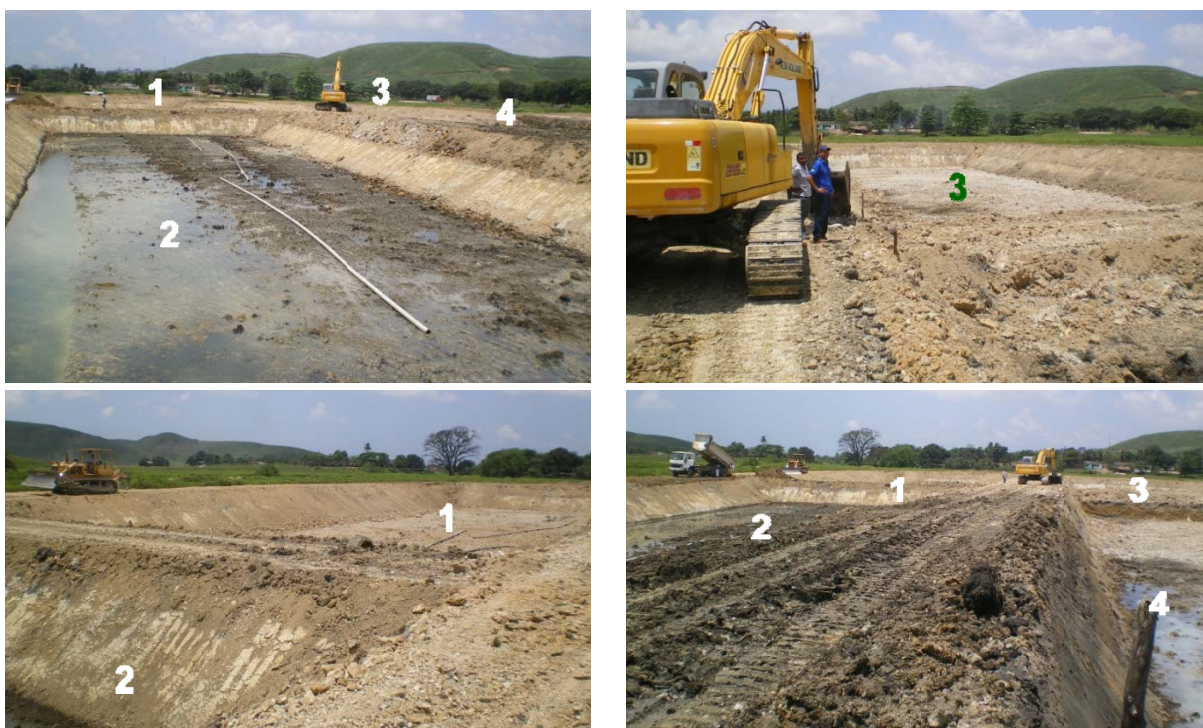
Figura 5.37: Construção de Lagoas - Dezembro de 2008
