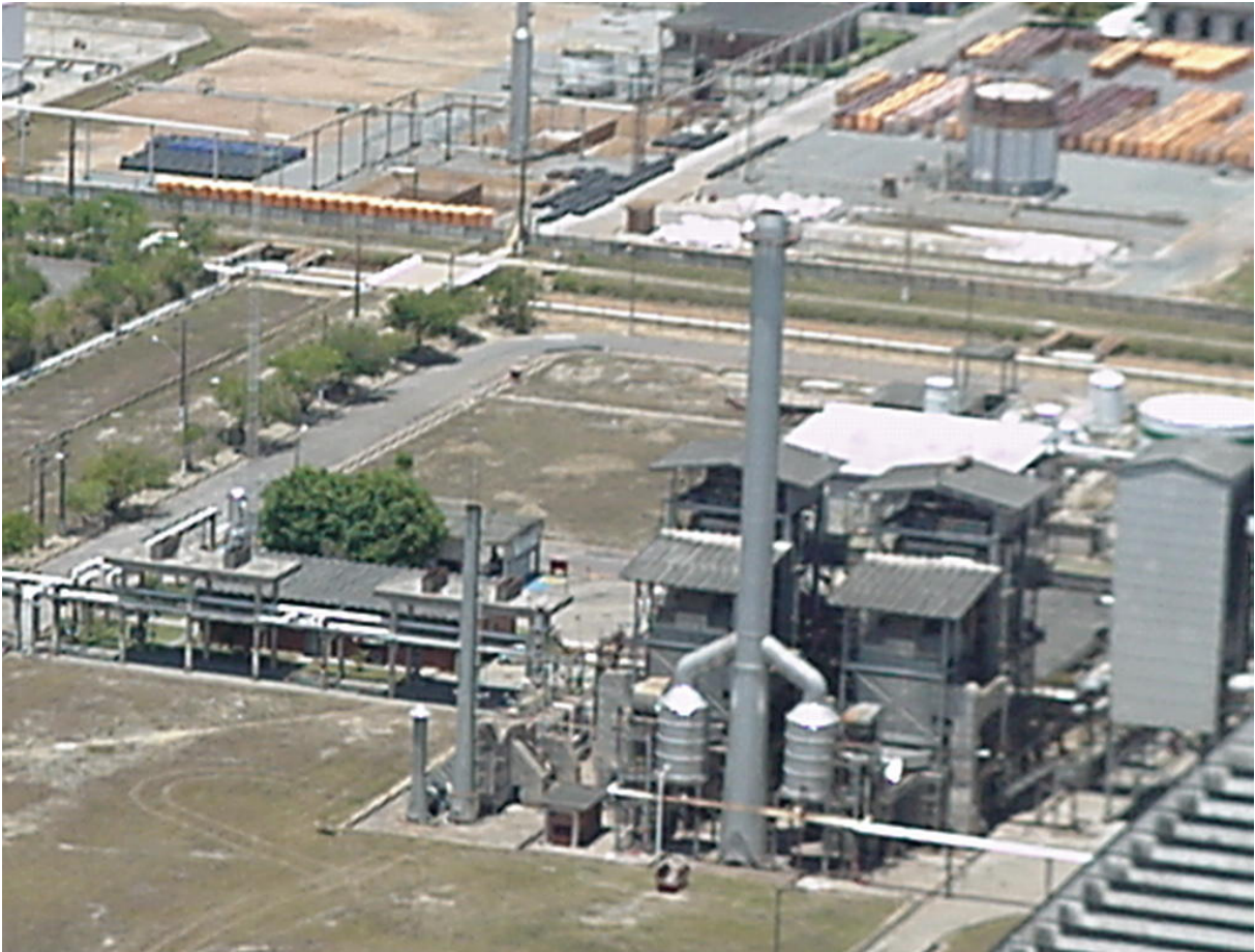
Figura 30- Vista aérea da geração de vapor.
