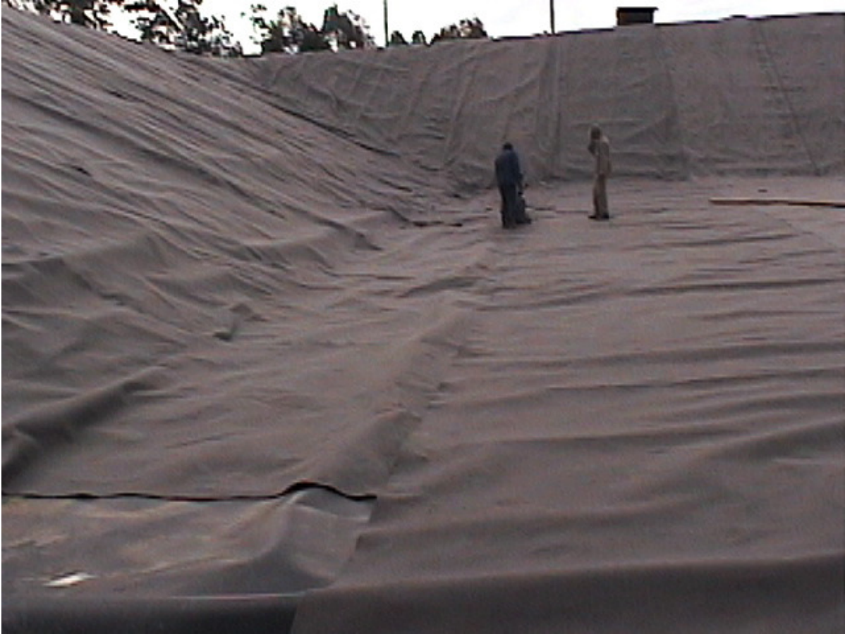
Figura 20- Vala de aterro classe I.
