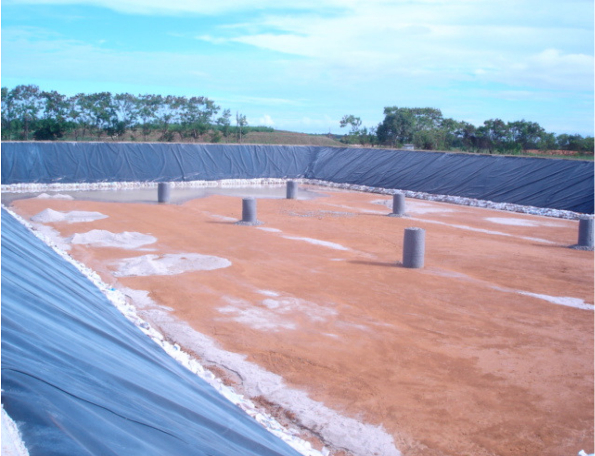
Figura 21- Vala de aterro classe II A.
