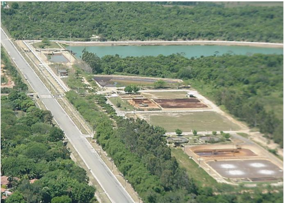
Figura 25- Vista aérea da unidade de tratamento de efluentes.
