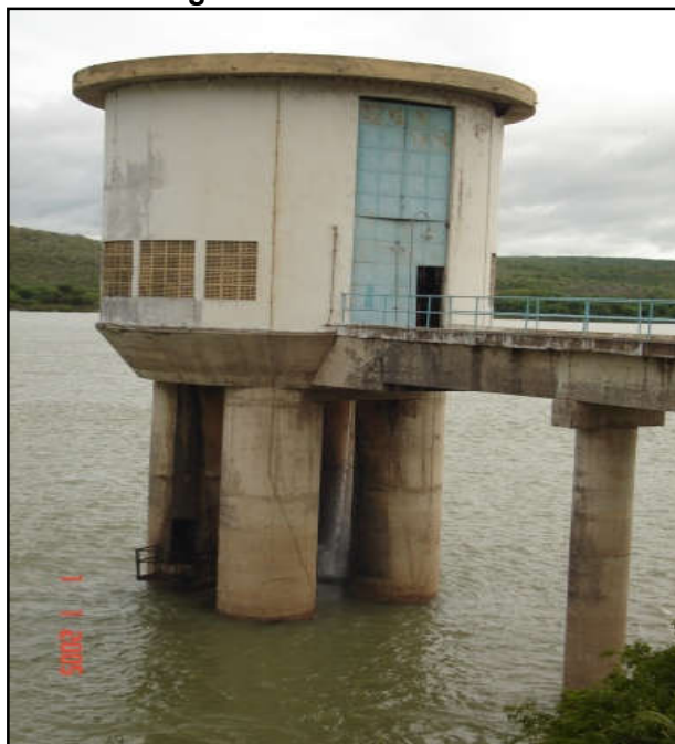
Figura3.3 – Tomada de água no rio São Francisco em Pão de Açúcar/Al
