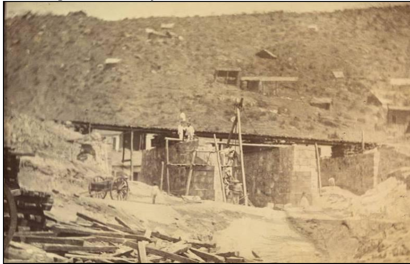
Figura 8. Construção da Estrada de Ferro Paulo Afonso
