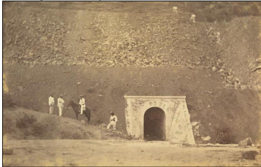
Figura 7. Construção da Estrada de Ferro Paulo Afonso
