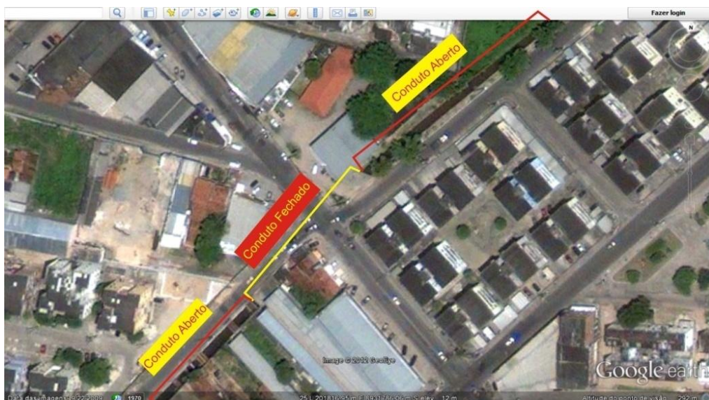
Figura 4.3. Ilustração da fragmentação em condutos fechados e abertos Fonte: Adaptado de Google Earth
