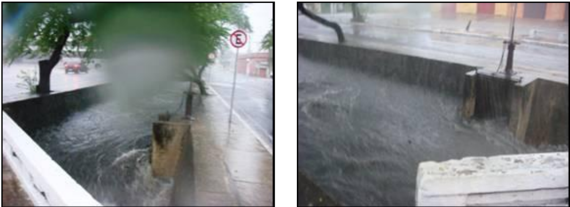
Figura 5.24. Evento observado por Pimentel que estimou a vazão de 15,24 \text{ m}^3/\text{s} Fonte: Pimentel, 2009
