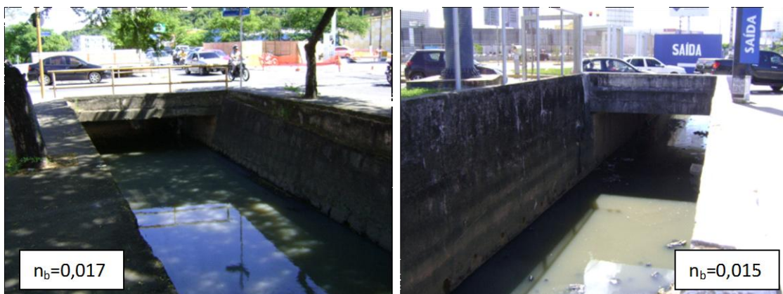
Figura 5.4. Tipos de revestimento encontrados ao longo do canal para a composição do n de Manning
