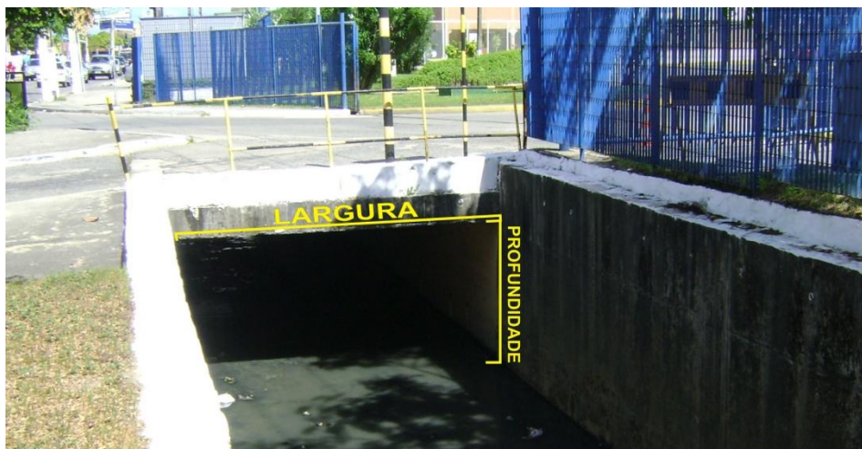
Figura 4.5. Levantamento da forma de condutos fechados
