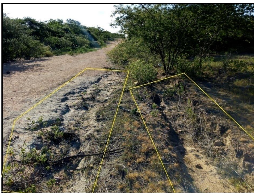
Figura 27: sulco erosivo em beira de estrada, decorrente do escoamento pluvial.
