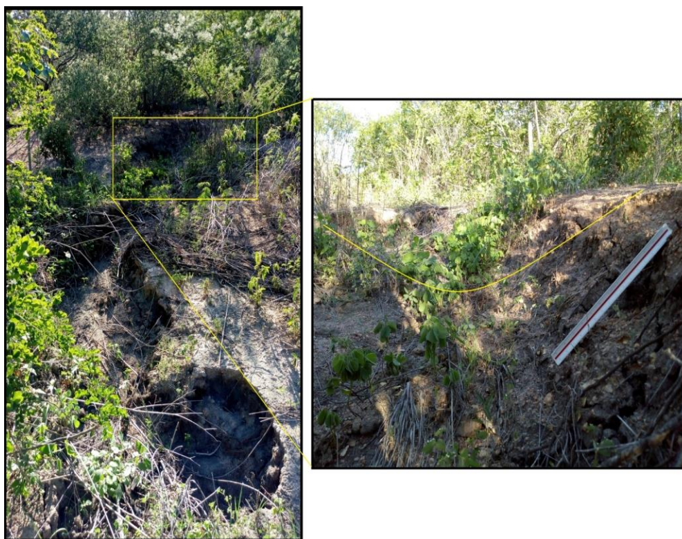
Figura 25: início de um sulco em desenvolvimento erosivo.
