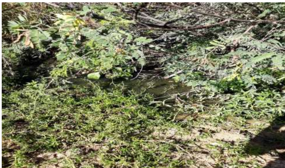
Figura 08: Local onde se inicia o esgotamento vindo das residências no entorno
