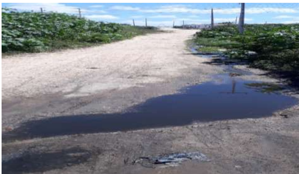
Figura 04: Esgoto oriundo do Conjunto Habitacional “369 casas”
