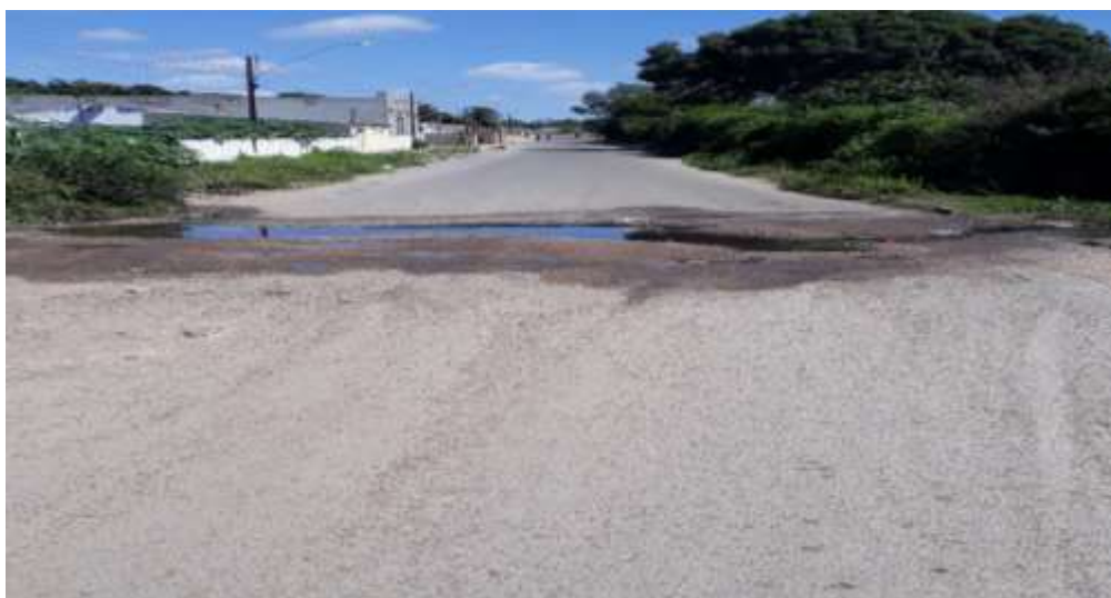
Figura 05: Esgoto atravessando a AL-220 Bairro Caraiberinhas
