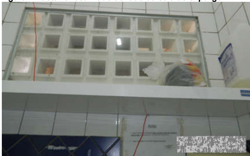
Figura 2-Lactário localizado ao lado da sala de expurgo
