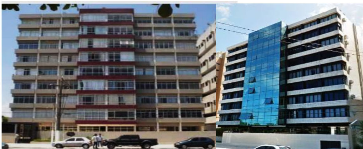
Figura 26 – Reforma edifício Donina Carneiro (1975)
