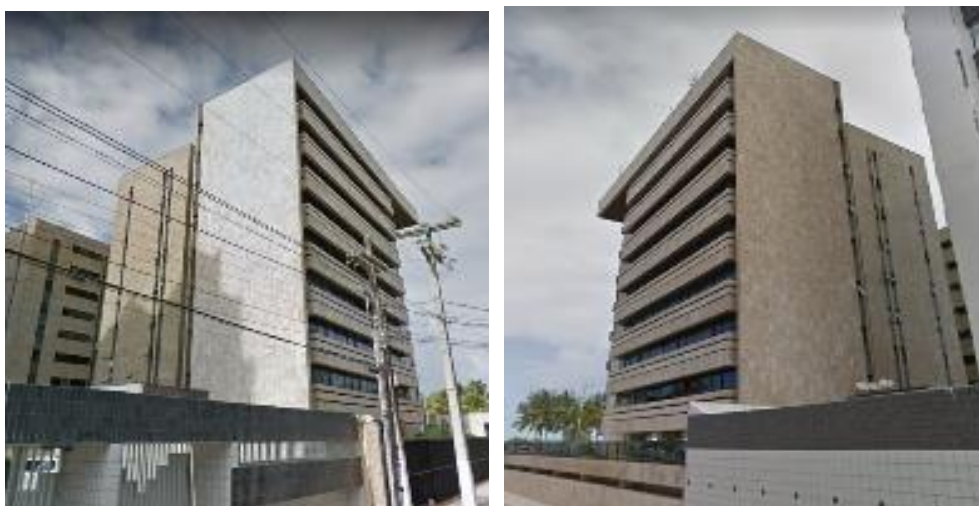
Figura 52 – Detalhes fachadas oeste e sul
