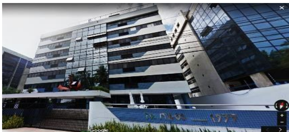
Figura 69 – Detalhes das varandas.
