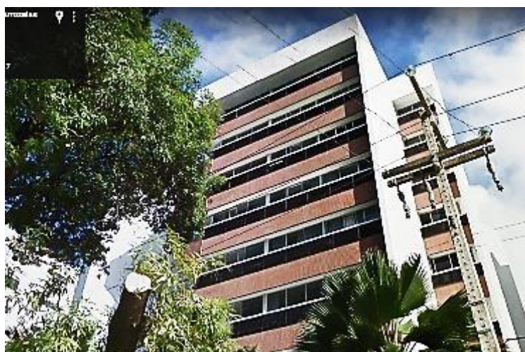
Figura 45 – Detalhe das varandas
