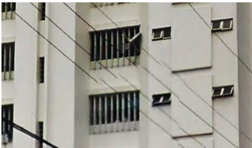
Figura 30 – Detalhe brises na área de serviço
