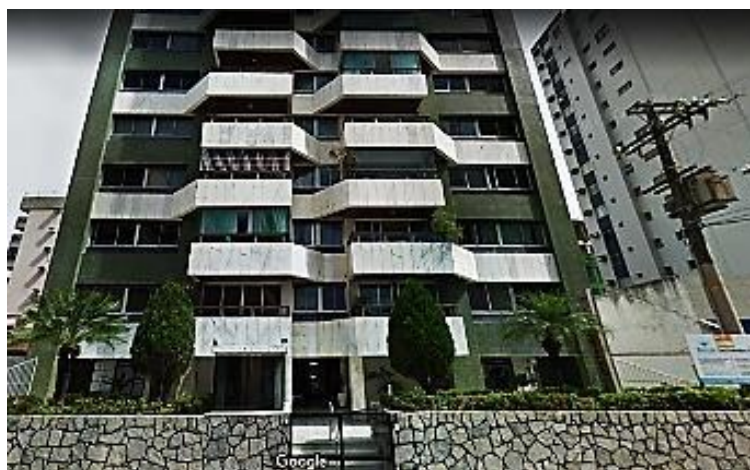
Figura 34 – Detalhes dos brises na área de serviço da edificação
