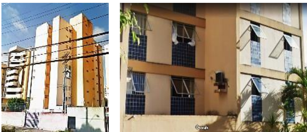
Figura 35 – Detalhes da fachada.
