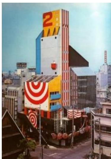
Figura 18 – (Building Number Two – 1970). Prédio comercial japonês, Ni-Ban-Kahn.
