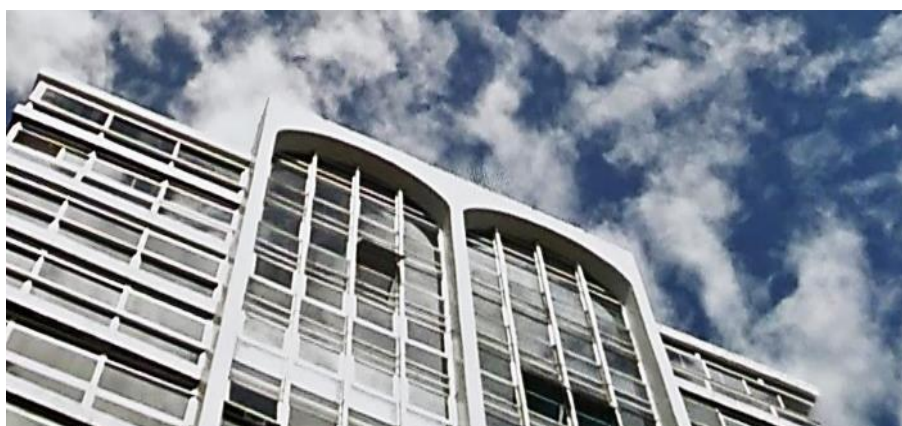
Figura 29 – Detalhe fachada – coroamento.
