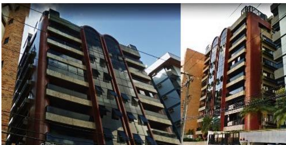
Figura 65 – Esquadrias de alumínio e vidro
