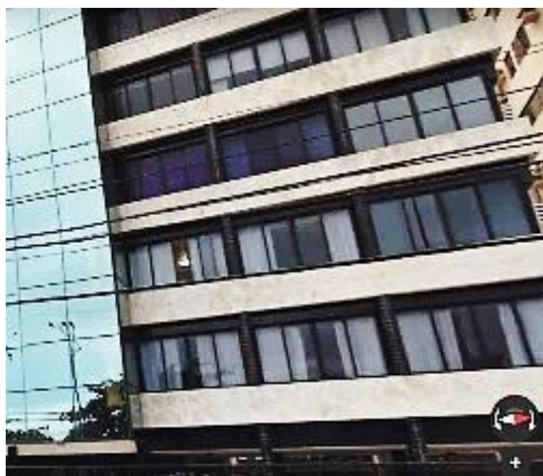
Figura 27 – Detalhe peitoril edifício Donina Carneiro (1975)
