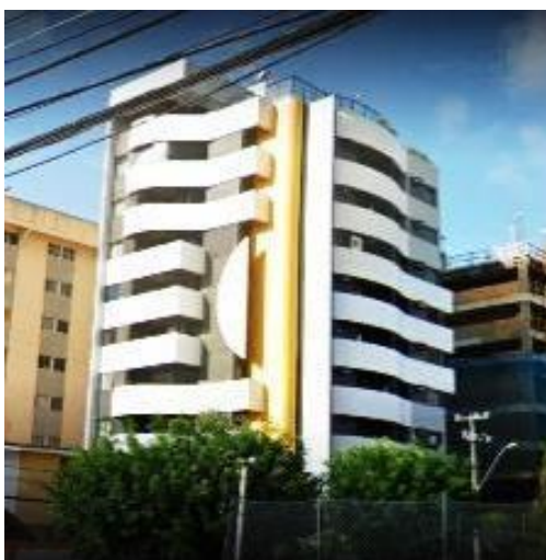
Figura 77 – Detalhe colocação de anteparo (semicírculo) para proteção solar.
