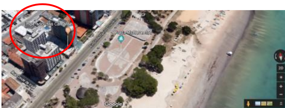
Figura 24 – Detalhe dos dois blocos, que compõem o edifício Jangada
