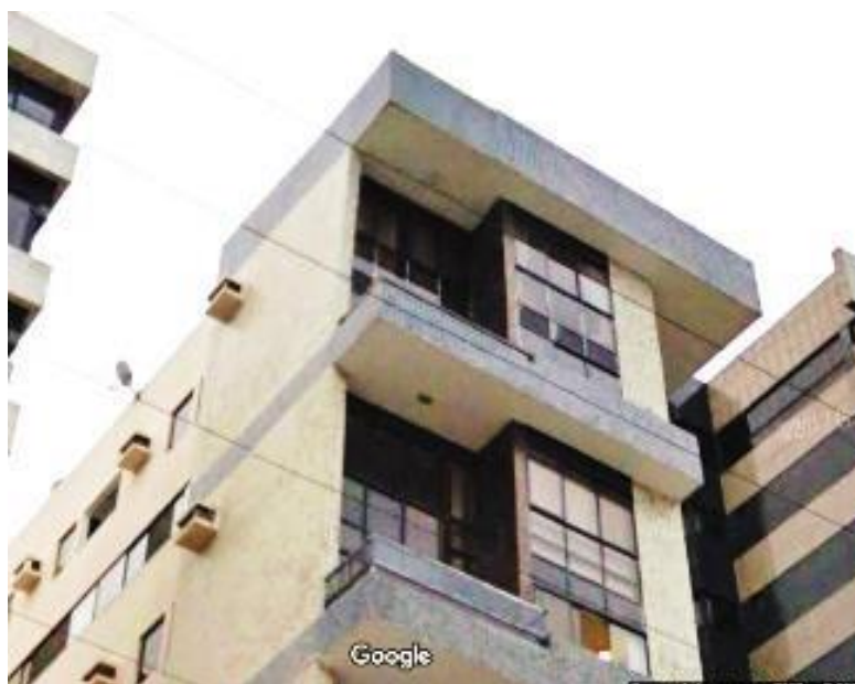
Figura 59 – Detalhes da fachada sudeste
