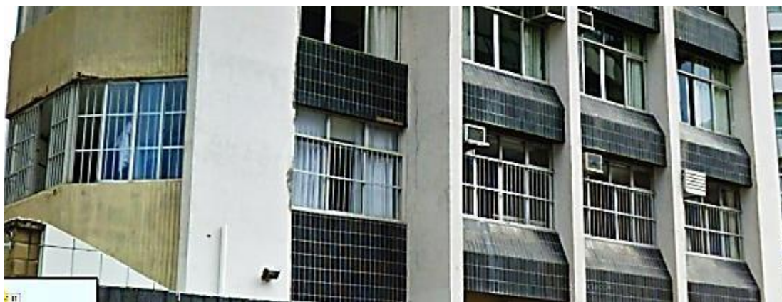
Figura 23 – Detalhe esquadrias e peitoril, no edifício Barroca (1970). Construído em concreto em formato “inclinado” foi revestido em cerâmica na cor preta Fonte: Disponível em < https://www.google.com.br/maps >
