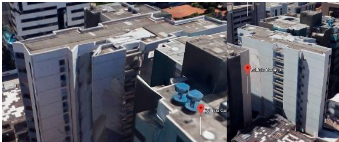
Figura 43 – Desgaste na fachada Sul e Norte
