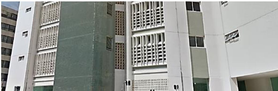
Figura 32 – Detalhes dos brises na área de serviço da edificação.
