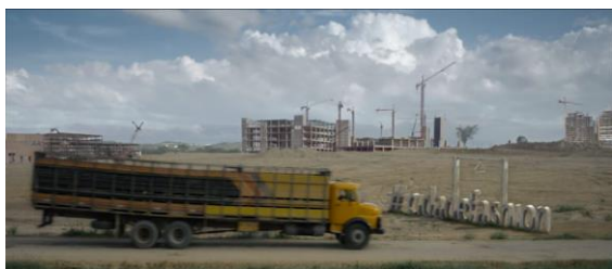
Fig. 142: Um centro comercial em construção
