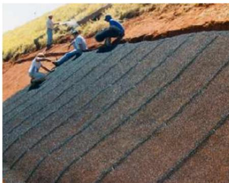
Fig. 5. Uso de Geomantas para controle de erosão.
