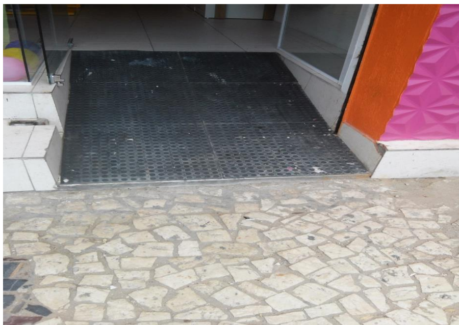
Figura 638: Rampa com sinalização tátil de alerta.
