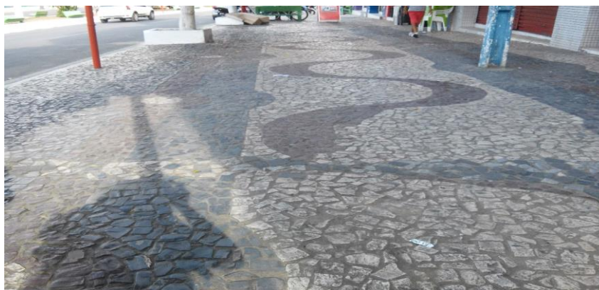
Figura 548: Demonstração do piso da calçada.
