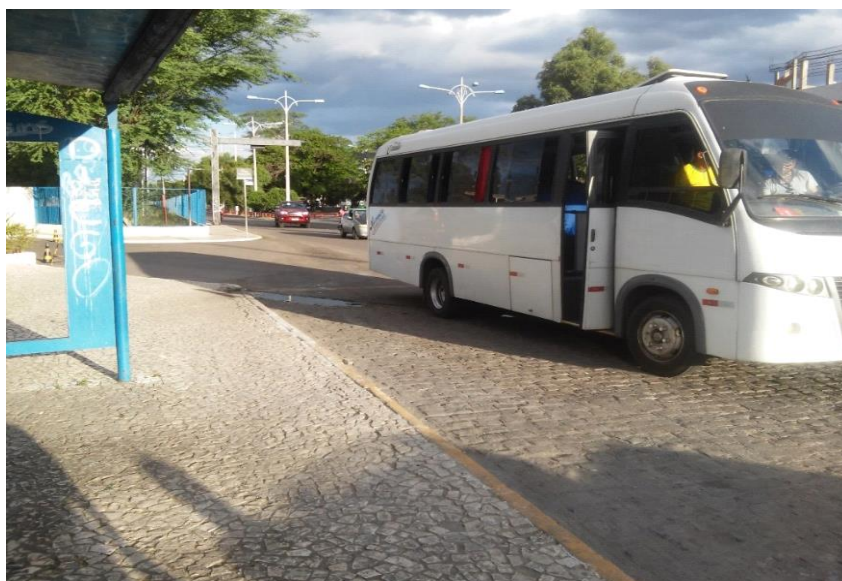
Figura 706: Área de acesso do ponto de ônibus sem sinalização.
