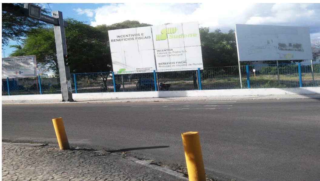
Figura 831: Travessia de pedestres apagada.
