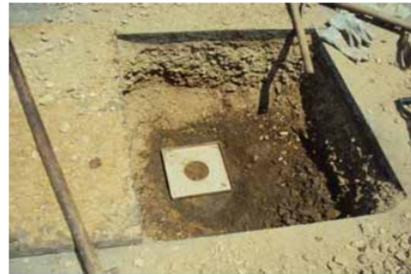
FIG. 16 - Abertura das Trincheiras na Rodovia
