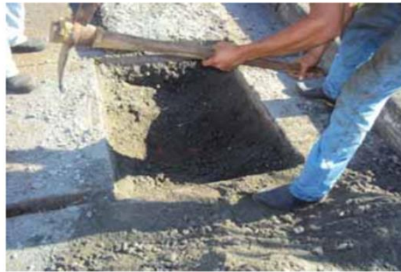
FIG. 16 - Abertura das Trincheiras na Rodovia
