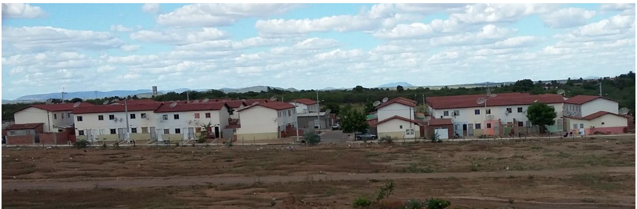
Figura 26 – Bloco D (central) e B (sul) do Condomínio Tancredo Neves.
