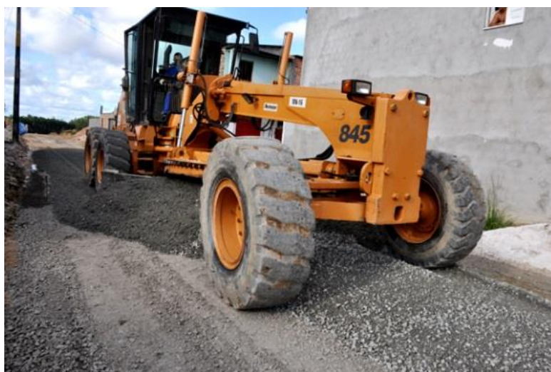
Figura 10 – Esparrame de solo-cimento por motoniveladora
