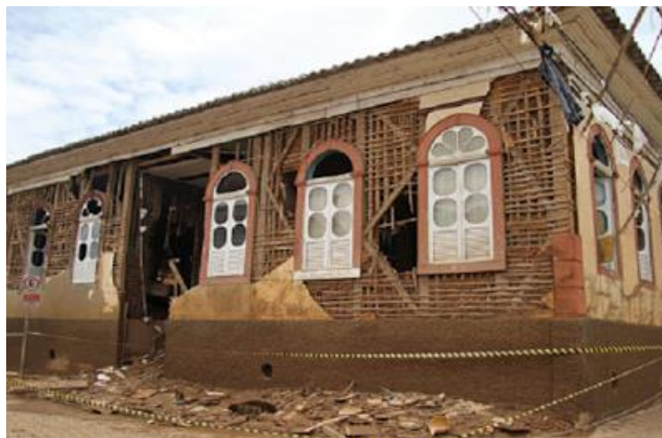
Figura 7 – Arquitetura à base de Pau-a-pique
