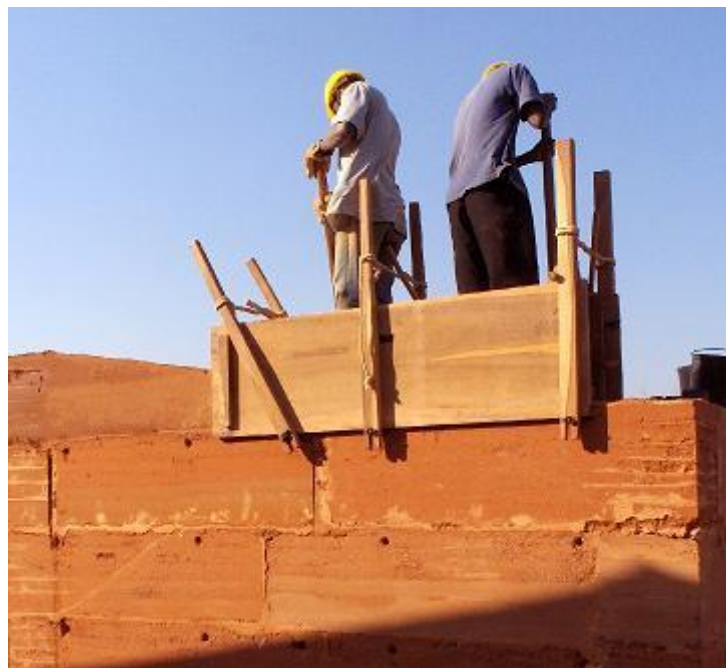
Figura 9 – Parede de taipa de pilão
