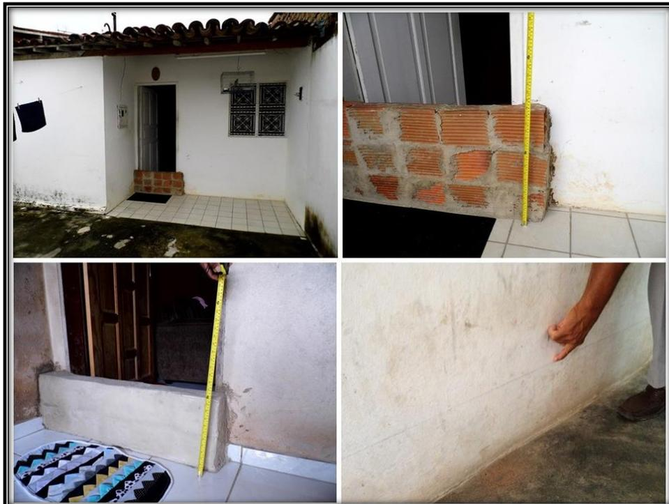
**Figura 26:** Construção de batentes para impedir a entrada das águas das chuvas nas residências.
