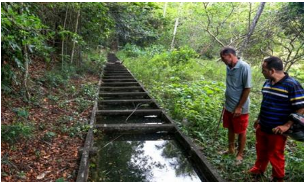
Figura 29: Canalização da água do açude para a laguna Mundaú
