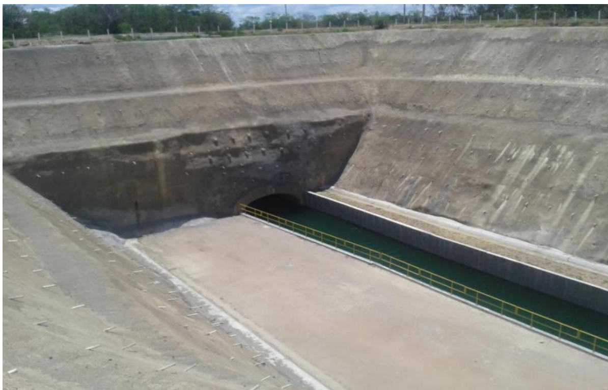
Figura 10 – Túnel no Canal do Sertão.
