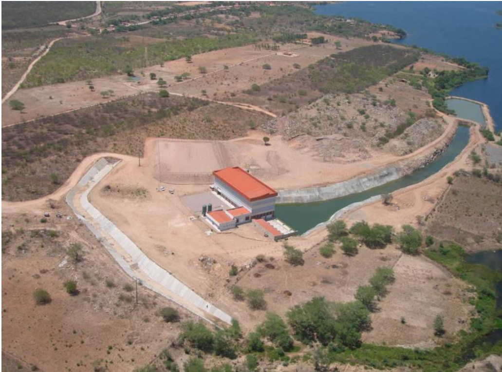
Figura 7 – Vista da tomada de água e estação elevatória do Canal do Sertão
