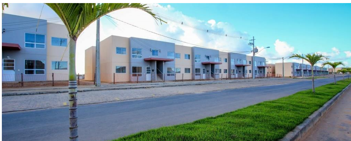
Figura 27. Modelo de edificação com 2 pavimentos adotado em seis empreendimentos em Maceió, AL. Imagem do Residencial Parque dos Caetés, no bairro Benedito Bentes. Fonte: TNH1, setembro de 2016.
