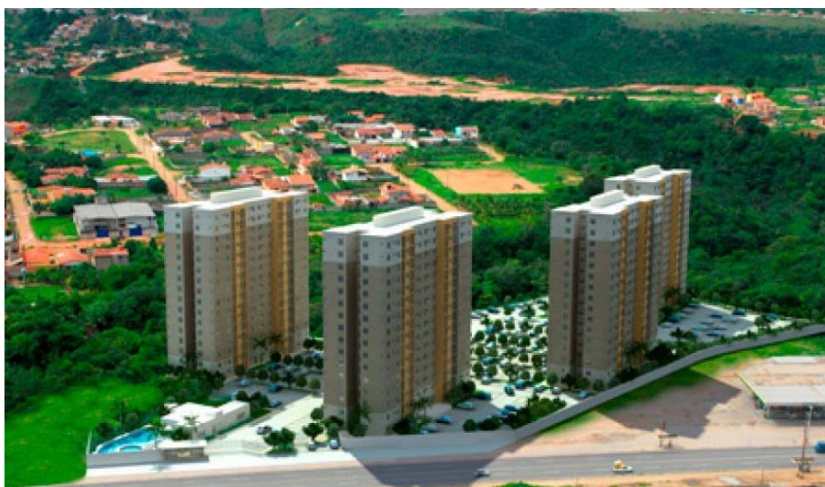
Figura 22. Exemplo de empreendimento vertical com elevador: Fit Parque Maceió, no bairro de Antares, Maceió, AL
