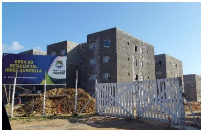
Figura 25. Residencial Jorge Quintela em construção no bairro Benedito Bentes Fonte: Arquivo pessoal, set.2015
