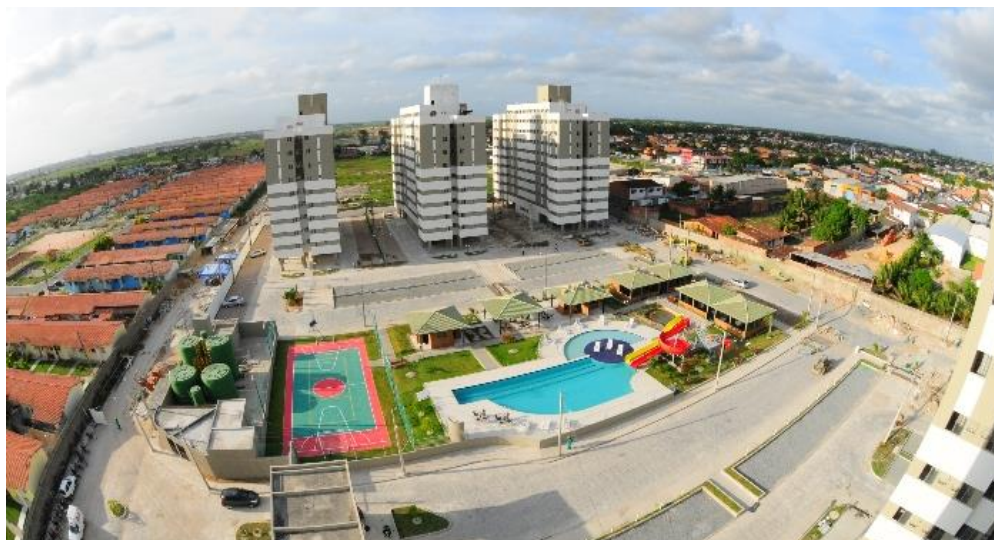
Figura 48. Vista interna do Condomínio Park Shopping 1, com destaque para a área de lazer. Fonte: Cerutti Engenharia, 2014.
