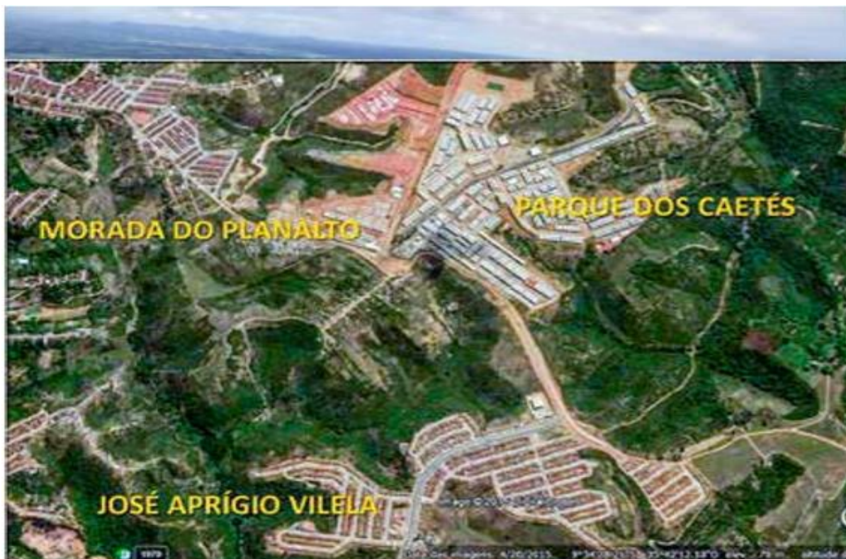
Figura 16 – Conjunto José Aprígio Vilela, Residencial Parque dos Caetés e Morada do Planalto. Fonte: CAVALCANTI, et al , 2015.
