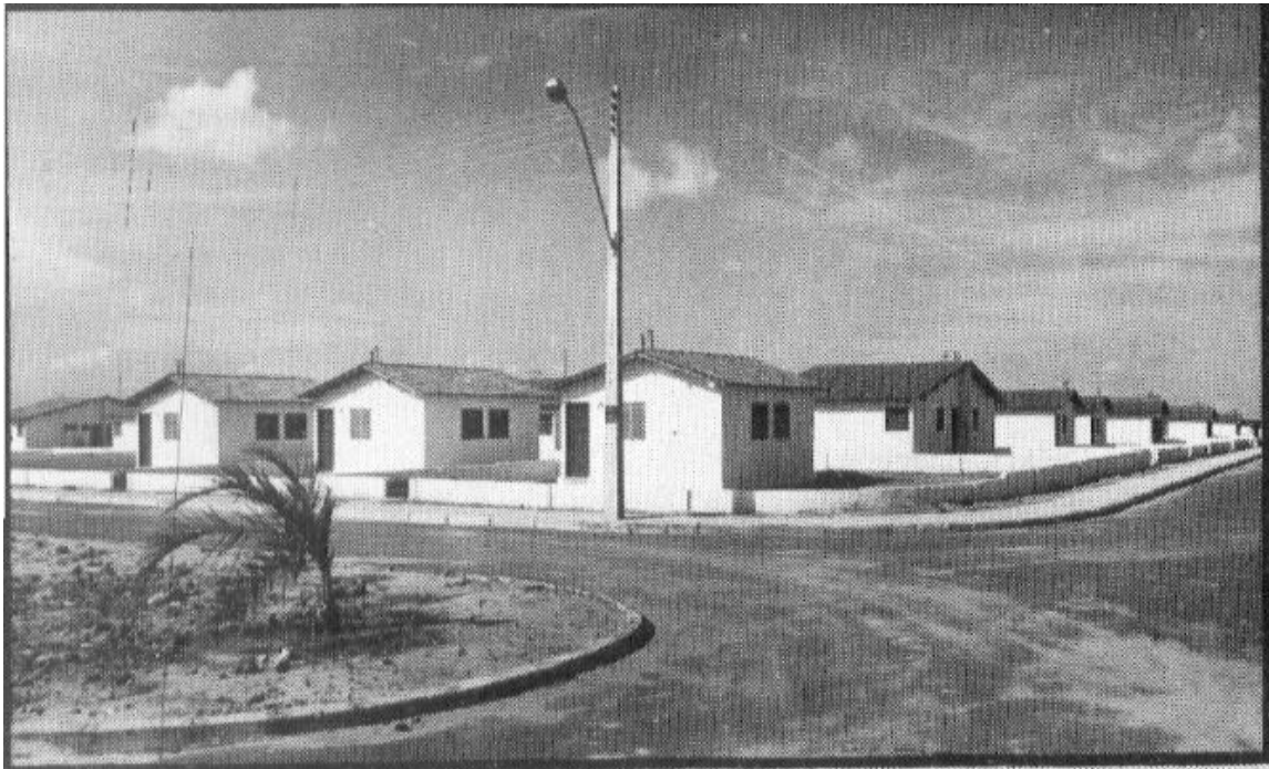
Figura8 – Etapa da construção no bairro Benedito Bentes, 1986. Detalhe para o tamanho do muro. Fonte: Instituto Histórico e Geográfico de Alagoas.
