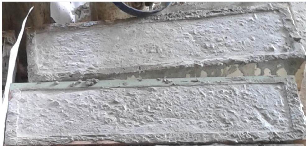
Figura 15 – Moldes usados na concretagem.
