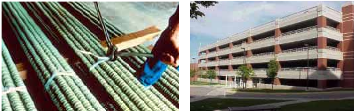
Figura 3.1. Barras pintadas com epóxi, à esquerda e edifício garagem nos EUA, utilizando inibidores de corrosão no concreto, à direita (CRSI, 2007; AXIM, 2007).
