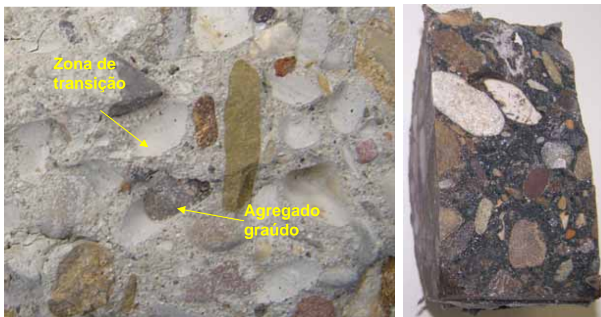
Figura 2.5. Detalhes de peças de concreto rompidas à compressão, à esquerda e à tração, à direita.
