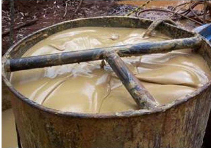
Figura 3.9 – Reservatório contendo fluido de perfuração.
