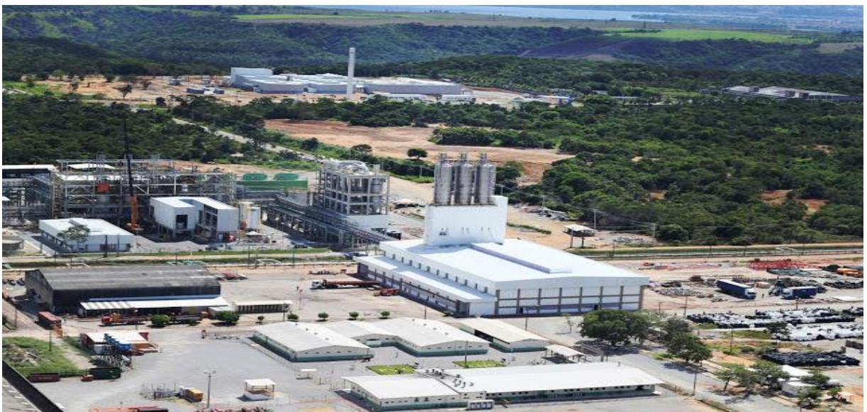
Figura 18 - Imagem aérea Braskem unidade PVC
