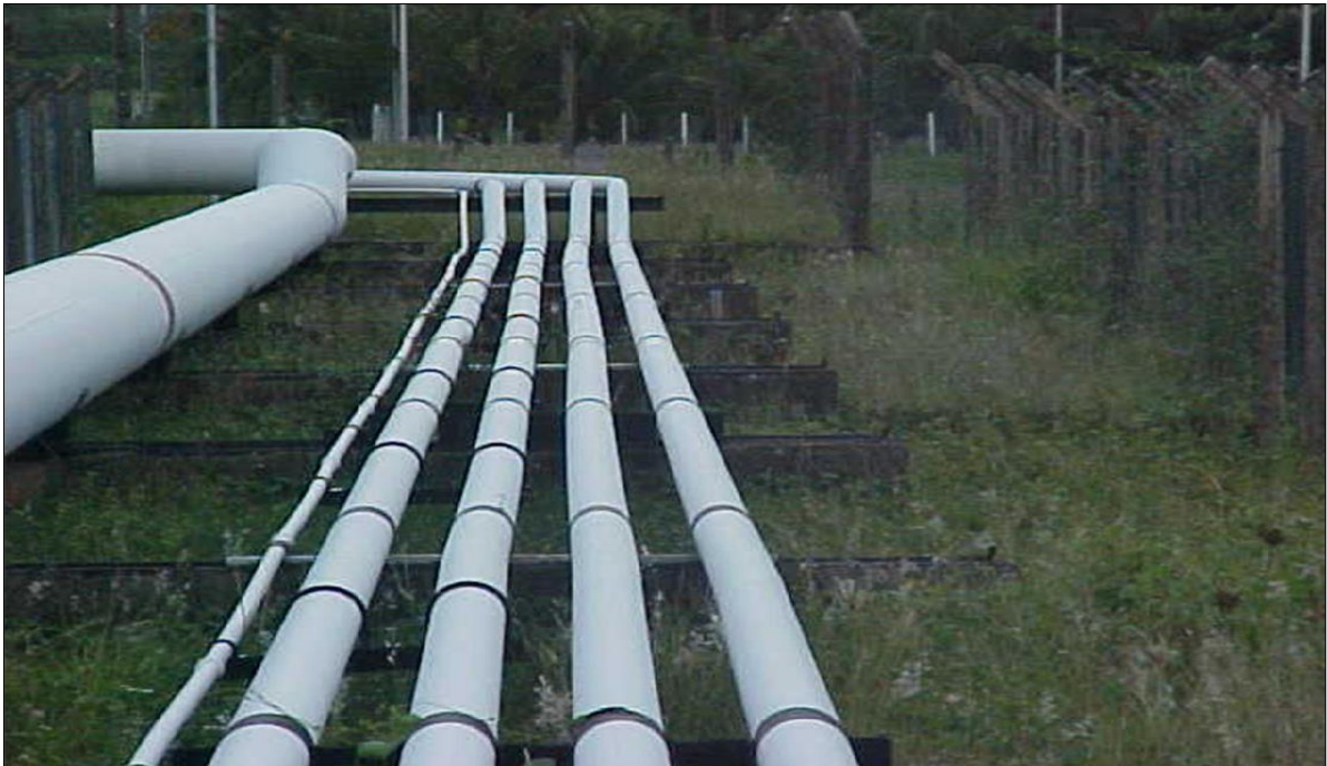
Figura 23 - Imagem dos dutos instalados.
