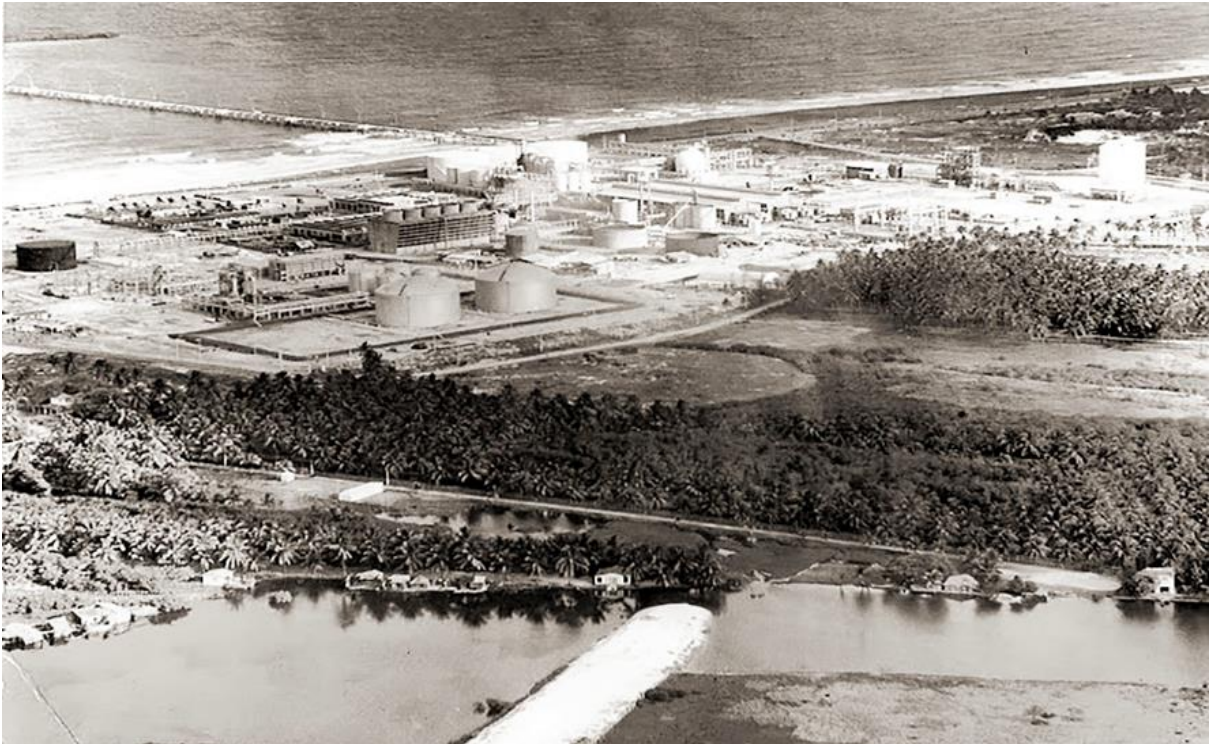
Figura 6 - A construção da fábrica de cloro soda, o campo de salmoura e o terminal marítimo, em Maceió, teve início em 1974.
