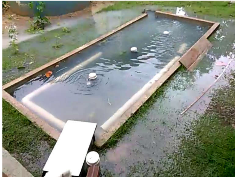
Figura 3. 10: Extravasamento da biorretenção do 22/07/2015 por volta de 12:00.
