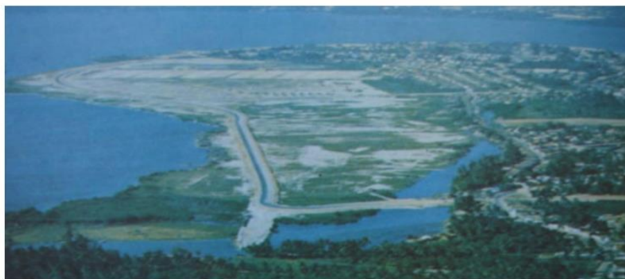
Figura 7 – Aterramento para o Dique-Estrada
