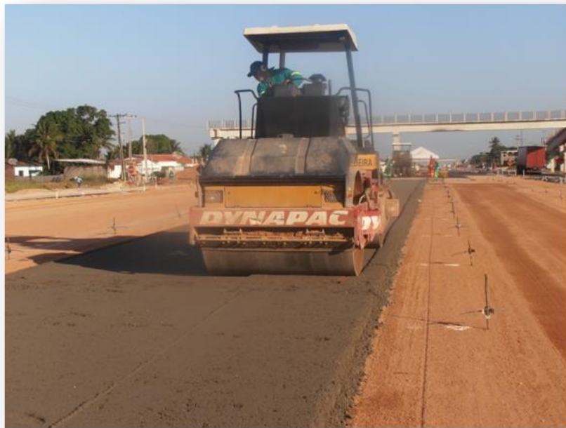
Figura 42 – Sub-base em concreto compactado a rolo - CCR
