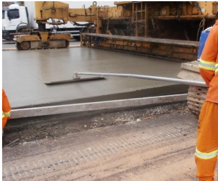
Figura 20 – Execução de pavimento rígido com vibro-acabadora
