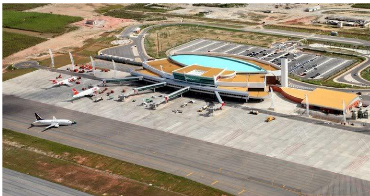
Figura 18 - O “novo” terminal de passageiros do Aeroporto Zumbi dos Palmares
