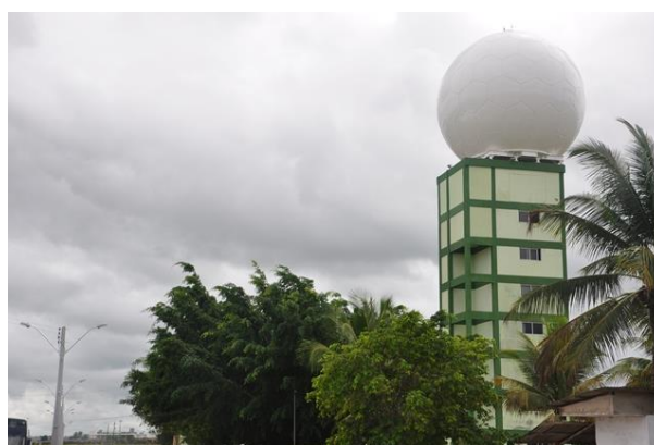
Figura 4.6 Conjunto pedestal, refletor e antena (com a proteção de uma cúpula) do radar S-POL SIRMAL do CEMADEN. Estrutura metálica (dentro da cúpula) contém os transmissor, receptor e demais subsistemas.
