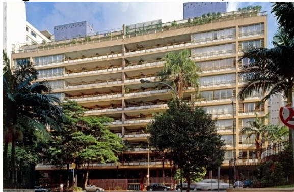
Imagem 2.3 - Edifício Prudência, São Paulo.
