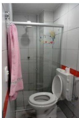
Imagem 5.18 - Antigo banheiro de serviço
