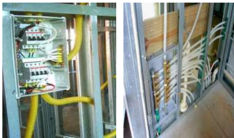
Figura 42 e 43 - Instalações Elétricas e Hidráulicas.
