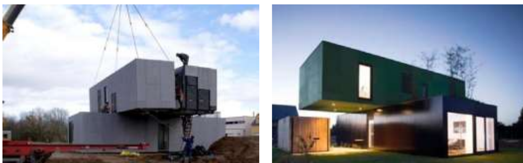
Figura 31 e 32- Construção Modular. Fonte: Rego (2012).
