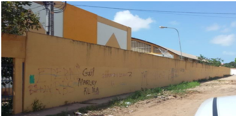
Figura 39 – Muro lateral da escola, antes da realização da etapa “Fazendo (p)arte do quadro social” Fonte: Autora, 2016.
