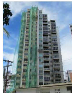
Figura 30 - Edif. Solar Graciliano Ramos em reforma
