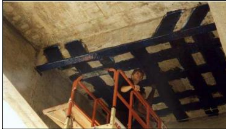
Figura 9-Laje e viga de um viaduto reforçadas com materiais compósitos.
