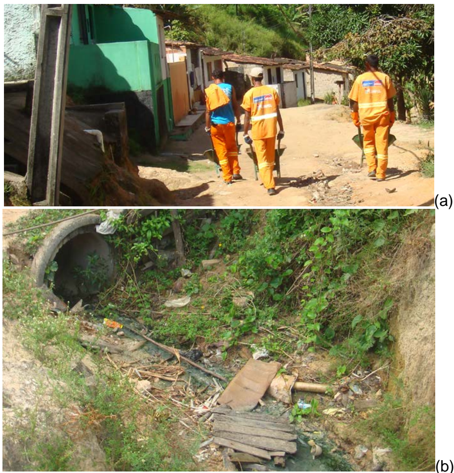
Figura 57 – Coleta de lixo e instalações elétricas em APPs de encostas nas proximidades da saída da macrodrenagem do Tabuleiro, bairro Benedito Bentes (06/07/10) (a) e esgoto lançado nos canais de drenagem no mesmo bairro (02/11/2010) (b)
