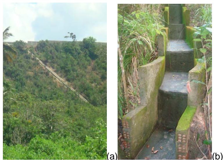
Figura 50 – Escada para drenagem de água pluvial vista ao longe (a); a mesma observada nas proximidades de uma das nascentes do rio Jacarecica (b).
