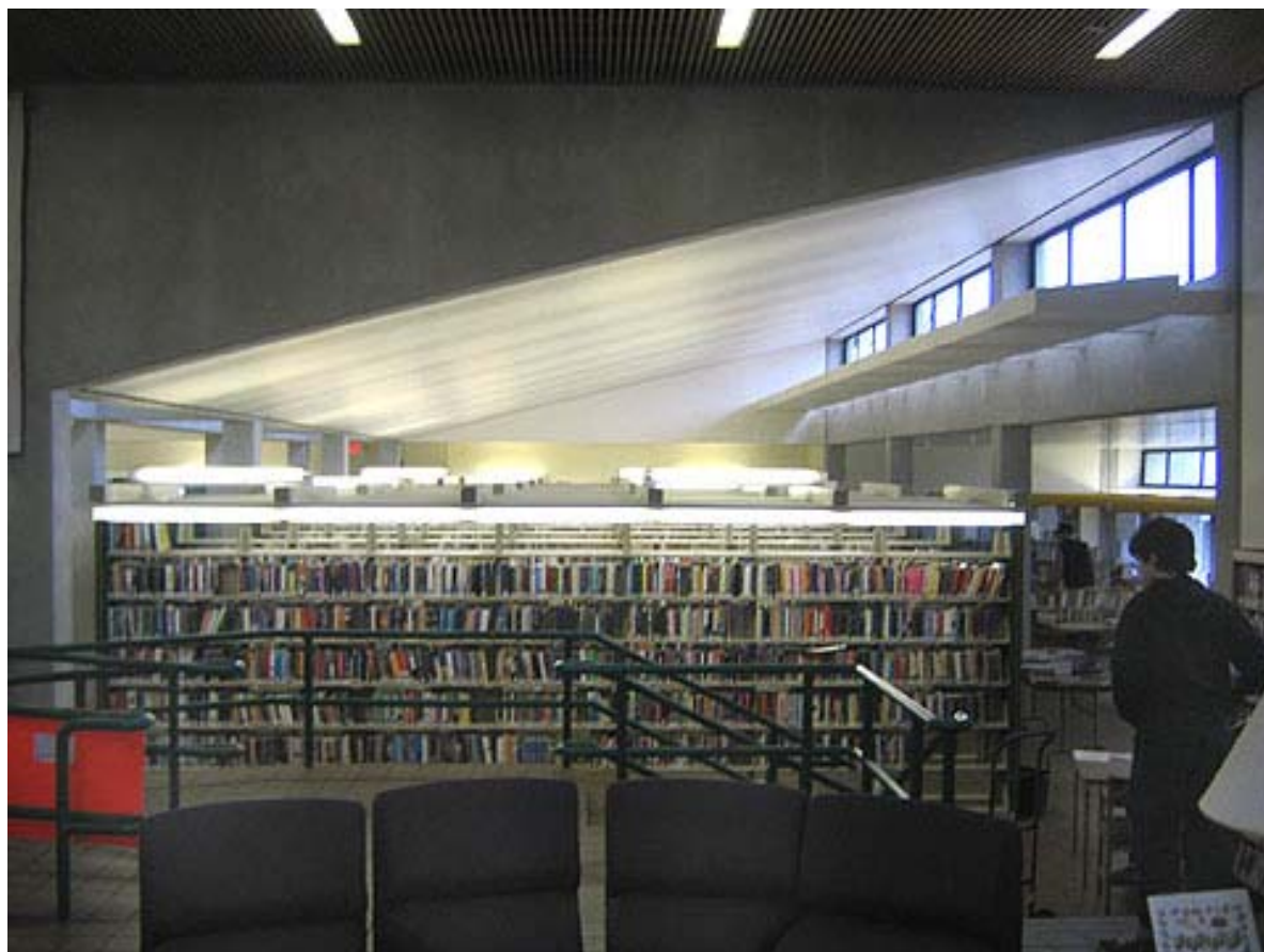
Figura 26 - Vista interna biblioteca pública de Mount Airy com detalhe para a prateleira de luz
