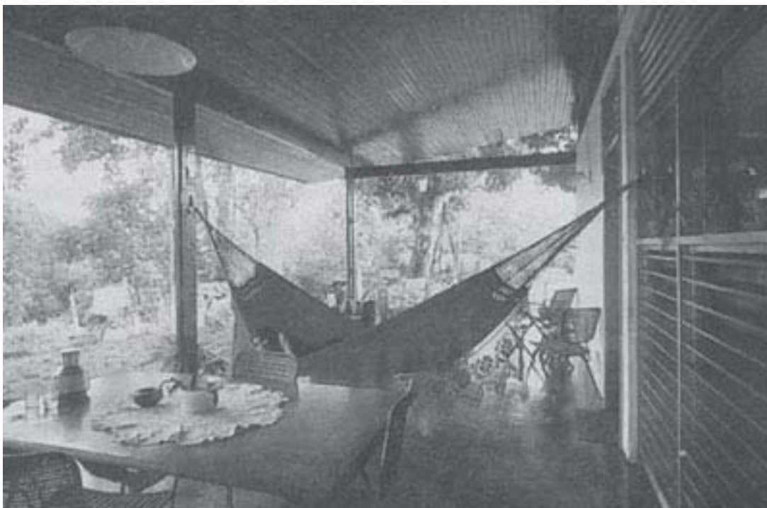
Figura 22 - Amplo beiral de casa na Vila Serra do Navio (Artur Bratke, 1955-60)
