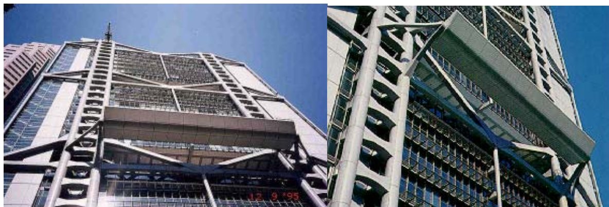
Figura 24 - Vista externa do HSBC com detalhe para a prateleira de luz
