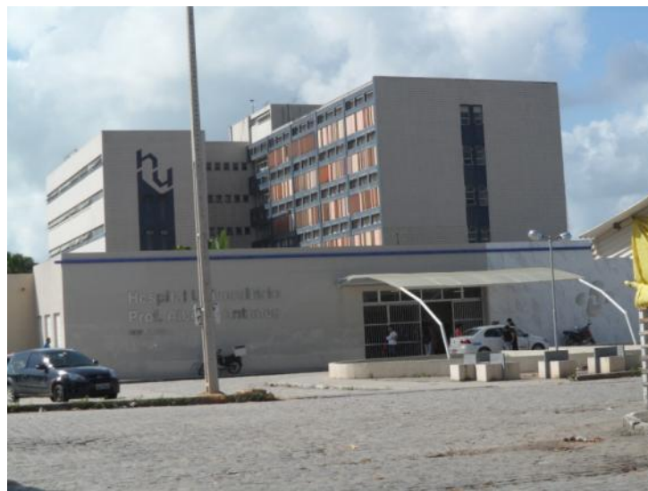
Figura 38- Imagem da fachada do ambulatório do Hospital Professor Alberto Antunes.
