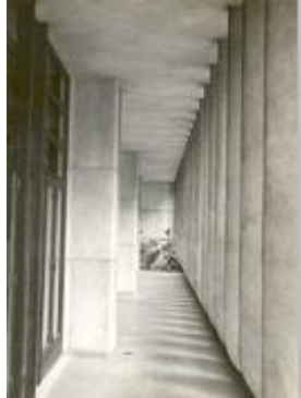
Figura 12 - Corredor do edifício-sede da ABI. À direita os brises em concreto.
