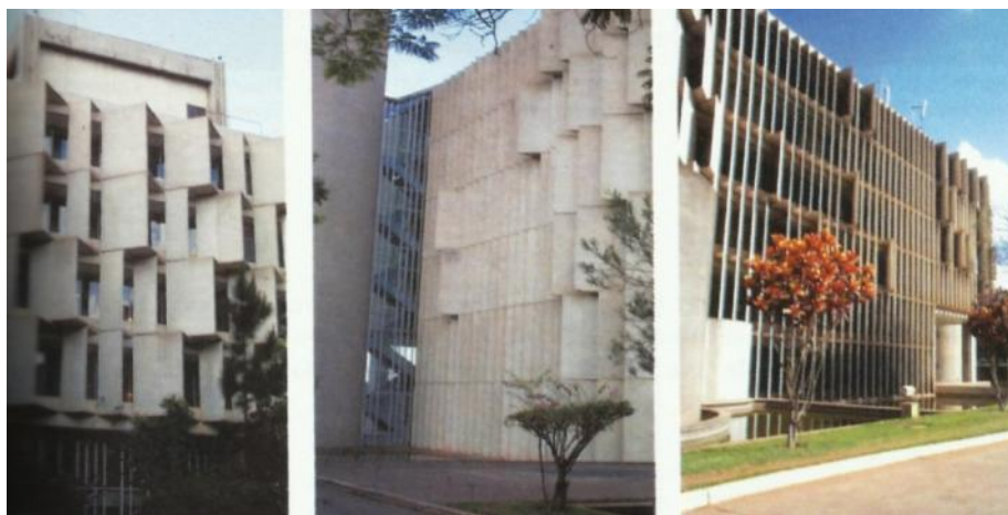
Figura 22- Fachadas do prédio do DNIT, Brasília- DF.
