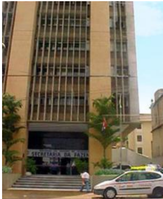
Figura 25- Edifício-sede SEFAZ , em Maceió-AL.
