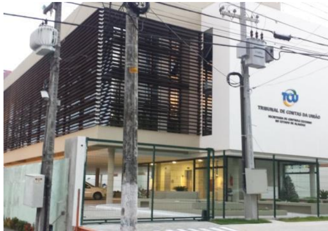
Figura 18 - Brises horizontais na fachada do Tribunal de Contas da União - Secretaria de Controle Externo no Estado de Alagoas
