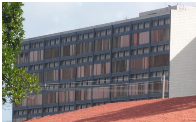
Figura 42- Foto da fachada ENE (ver orientação dessa fachada na figura 39).
