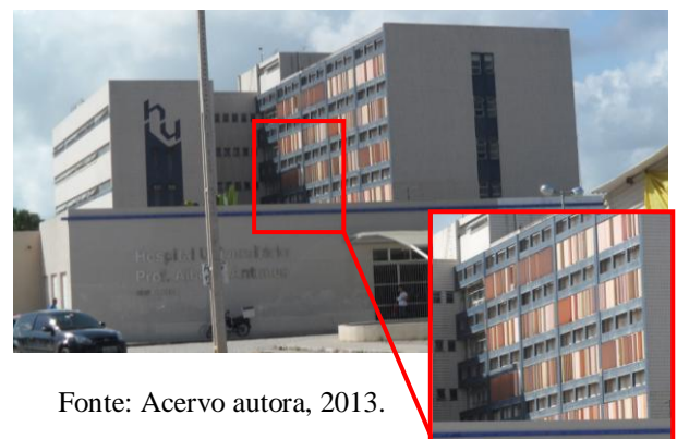
Figura 41- Foto da entrada do ambulatório, cujo acesso ocorre pela Rua 'B'. Detalhe para os brises móveis (ver orientação dessa fachada SEE na figura 41).
