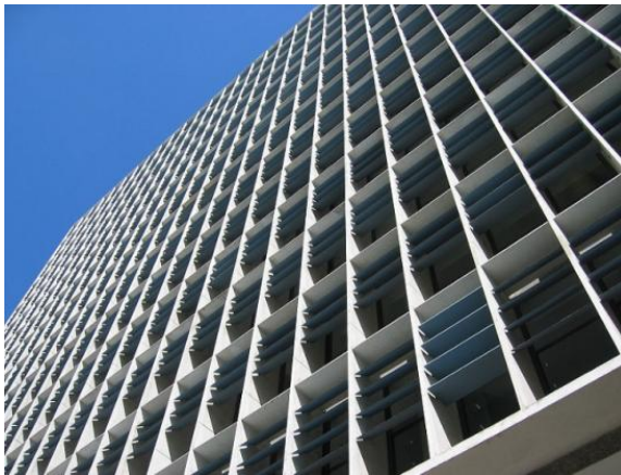
Figura 10- Fachada Norte do Edifício Gustavo Capanema, Rio de Janeiro.
