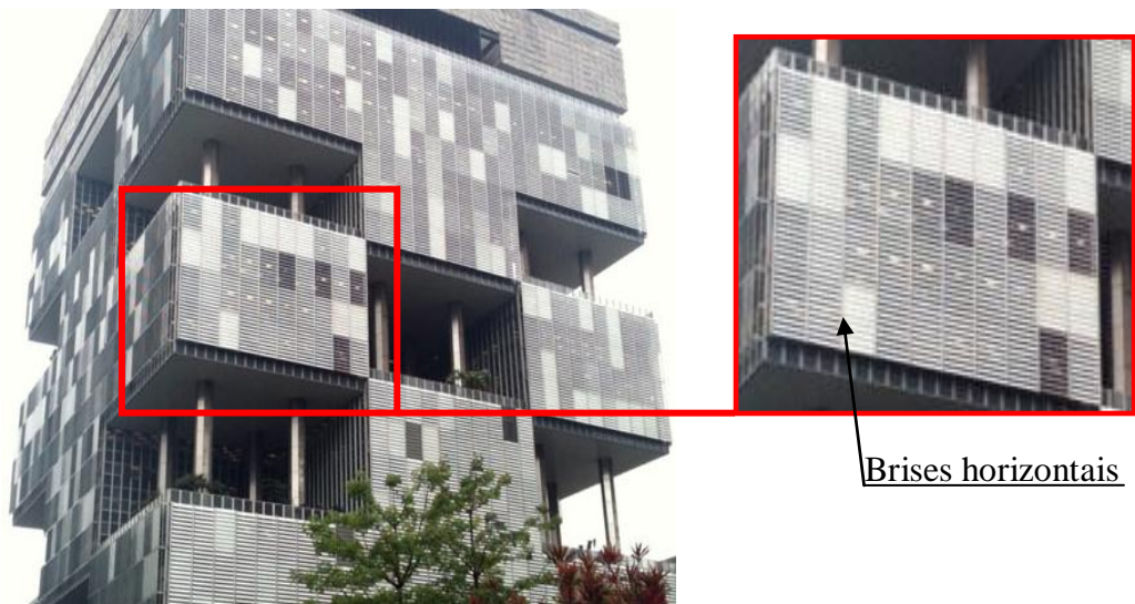
Figura 16 - Edifício Sede Petrobrás (1968), Rio de Janeiro. Destaque para os brises horizontais da fachada Norte.
