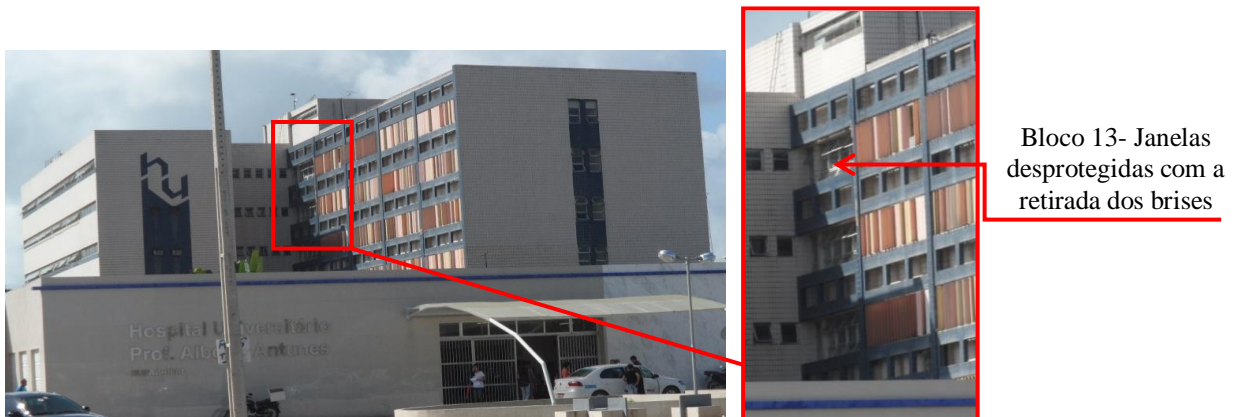
Figura 52- Foto fachada OSO, com destaque para o brise do bloco 13 e as janelas sem brises.
