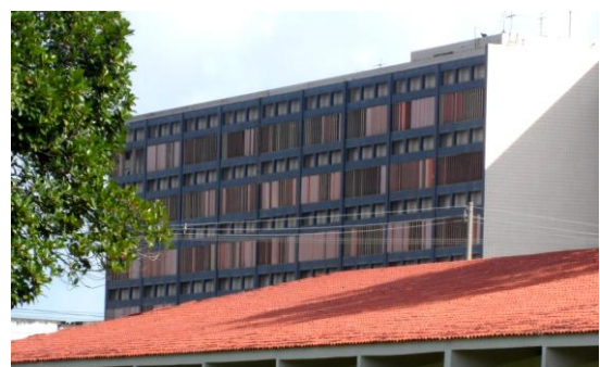
Figura 54- Foto fachada ENE- blocos 11, 12 e 13.
