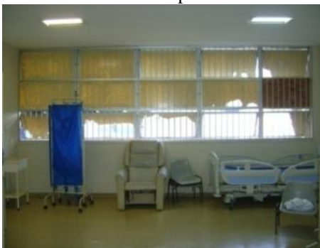
Figura 53- Foto da enfermaria onde os brises não foram repostos.
