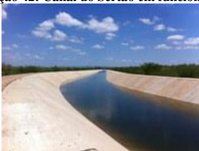
Ilustração 42: Canal do Sertão em funcionamento
