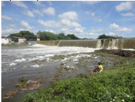
Ilustração 31: Açude Pedra Velha - Delmiro Gouveia
