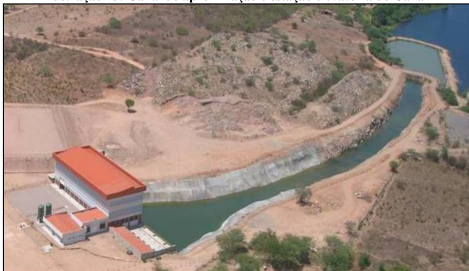
Ilustração 43: Canal de aproximação e estação elevatória do Canal
