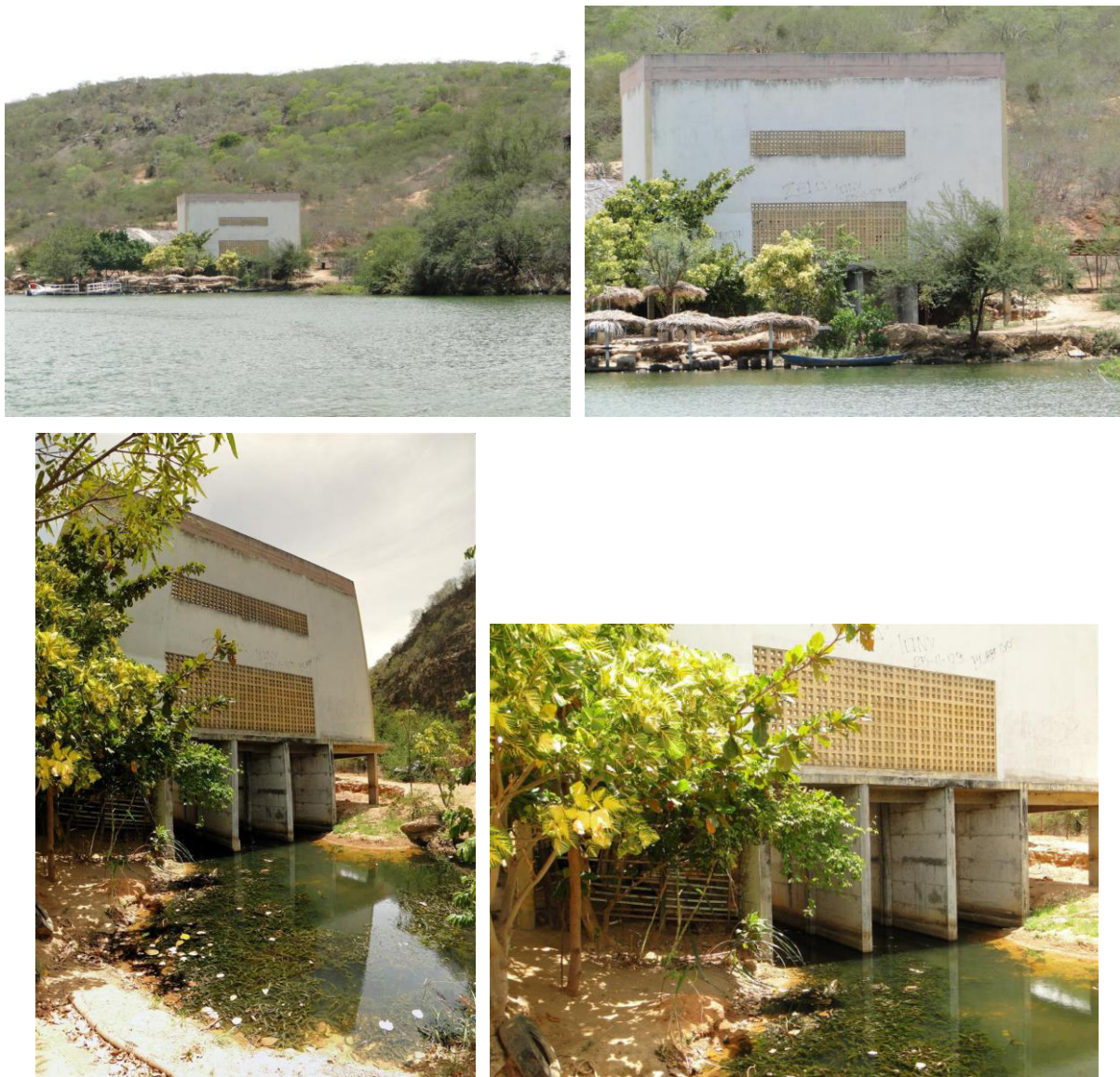
Ilustração 40: Projeto abandonado às margens do rio São Francisco
