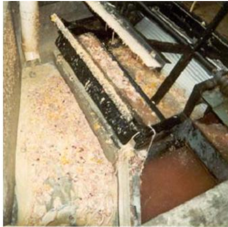
Figura 1 – Peneira com limpeza mecânica da Tecma, instalada em um abatedouro de aves.
