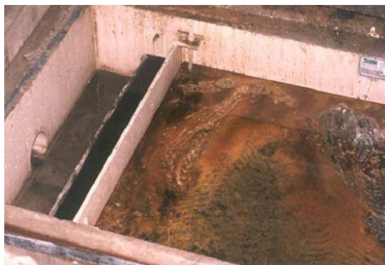
Figura 2 – Caixa separadora de água/óleo instaladas em um posto de serviço
