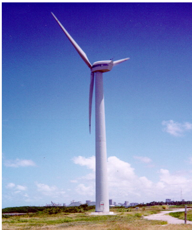
Figura 17. Central Eólica de testes de Olinda, estado de Pernambuco, com potência de 300 kW.
