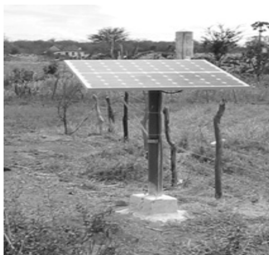
Figura 7a. Moto-bomba flutuante. Figura 7b. Painel fotovoltaico usado em bombeamento d'água. Fonte: Heitor Scalabrini Costa - Núcleo de Apoio a Projetos de Energias Renováveis (NAPER)
