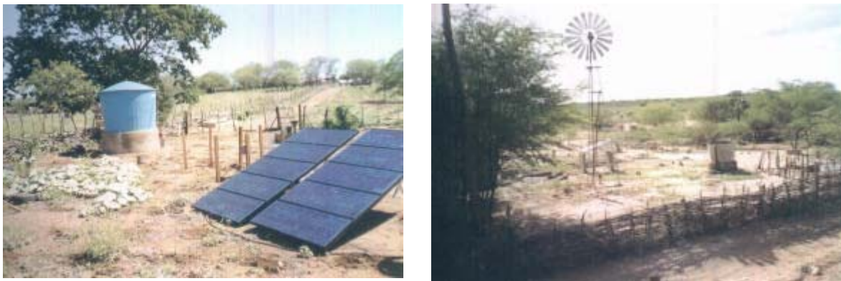
Figura 11. Sistemas fotovoltaico e eólico de bombeamento d'água nos municípios de Serra Talhada e Iguaraci, no estado de Pernambuco. Fonte: (PERNAMBUCO, 2004)
