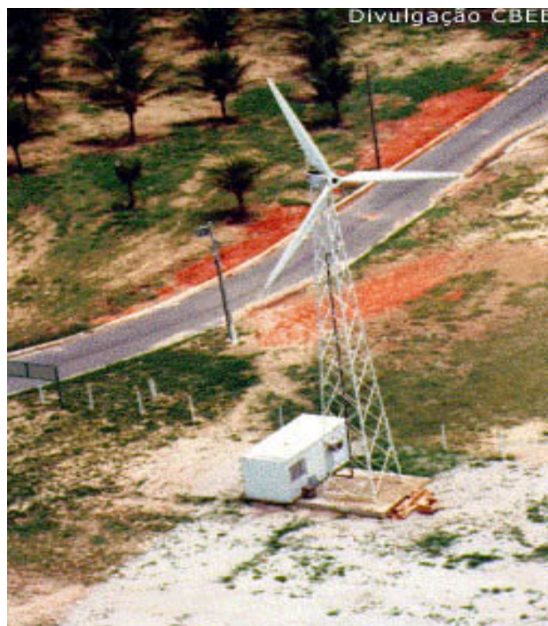
Figura 18. Turbina Eólica de 30 kW em Olinda, estado de Pernambuco. Destaque para o container de instrumentação instalado pelo CBEE.
