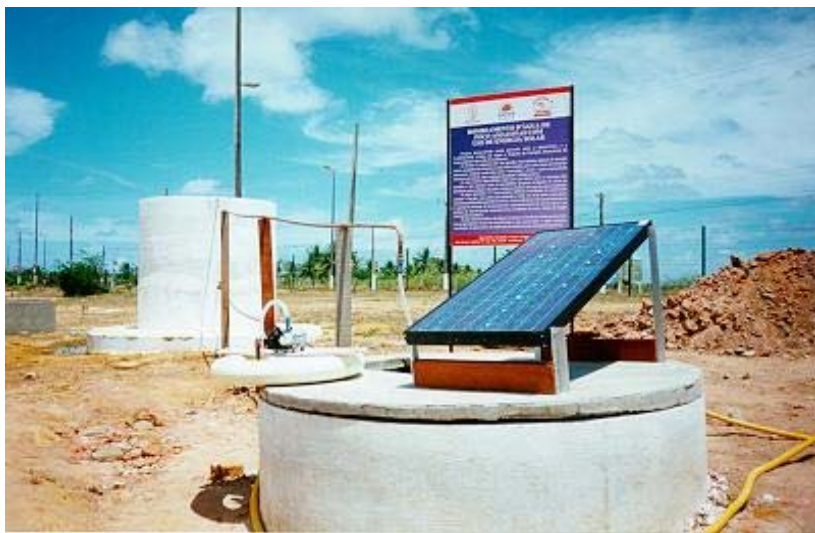
Figura 10. Uso de módulo fotovoltaico em bombeamento de água de poço amazonas no interior do Estado de Pernambuco Fonte: Núcleo de Apoio a Projetos de Energias Renováveis (NAPER)
