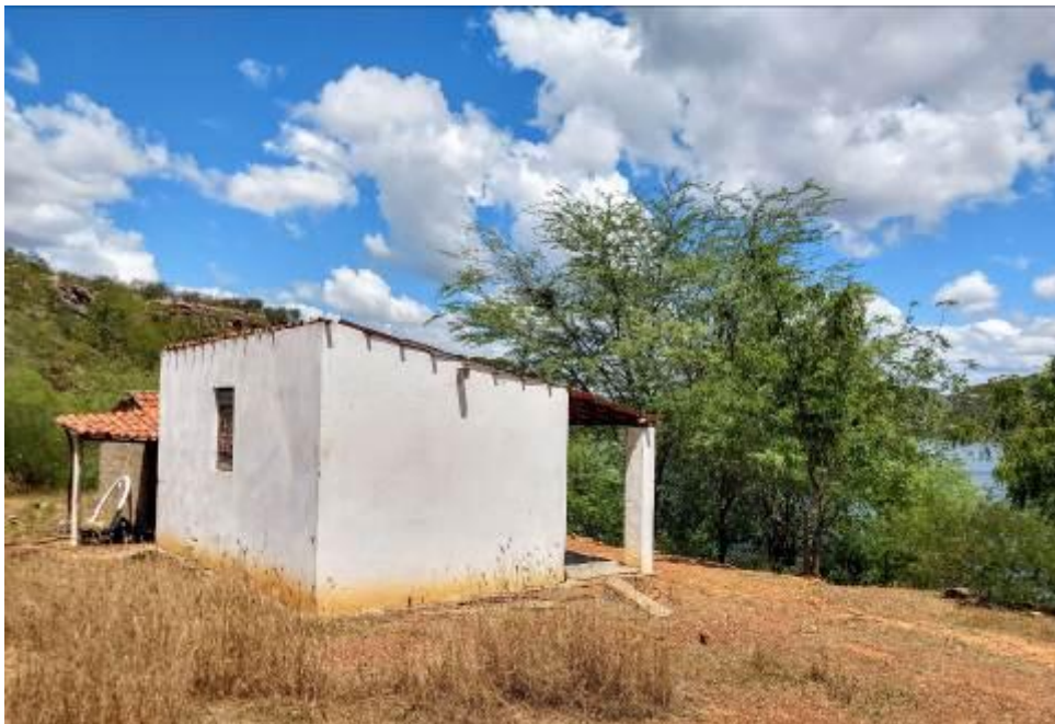
Figura 07: Casa de apoio à direita e armazém a esquerda construída pelo ITERAL às margens do lago de Xingó no Assentamento Lameirão, vista de outro ângulo. Fonte: Jefferson Araújo Nascimento, 2021.
