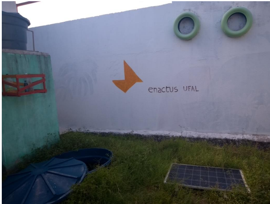
Figura 31 – Caixas d'águas e a placa de energia solar
