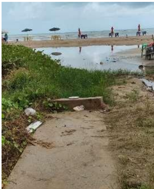
Figura 16: Ponto de lançamento de efluente
