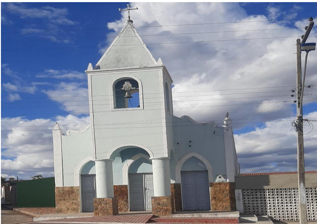
Figura 2: Igreja da Comunidade
