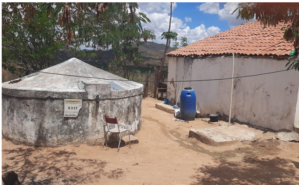
Figura 9: Cisterna de Placas na Comunidade.
