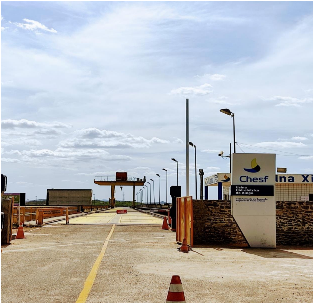
Fonte: a autora, Usina Hidrelétrica de Xingó, 2021.
