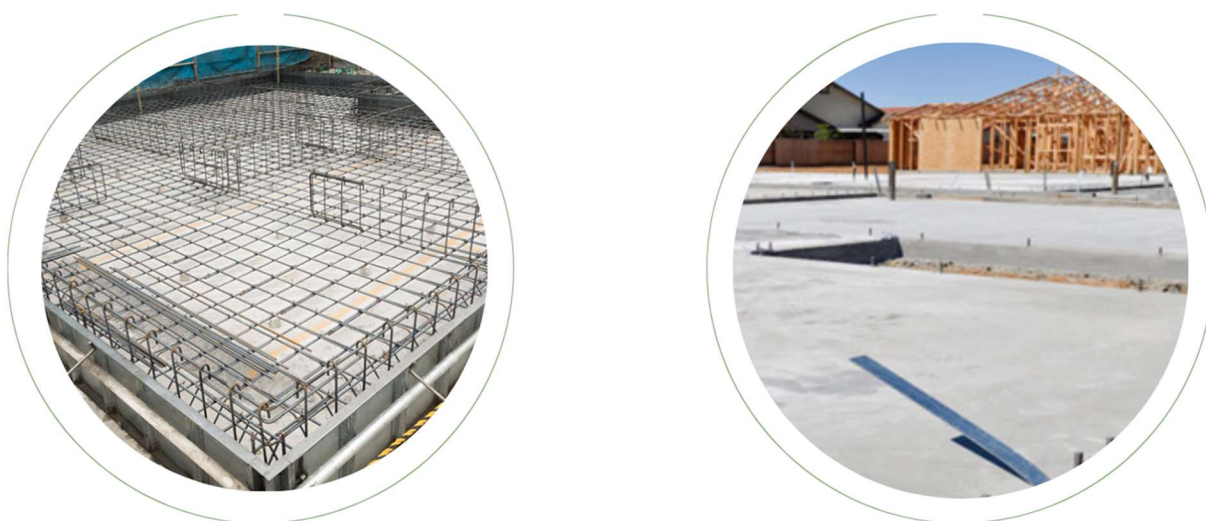
Figura 31 – Fundação em Radier
