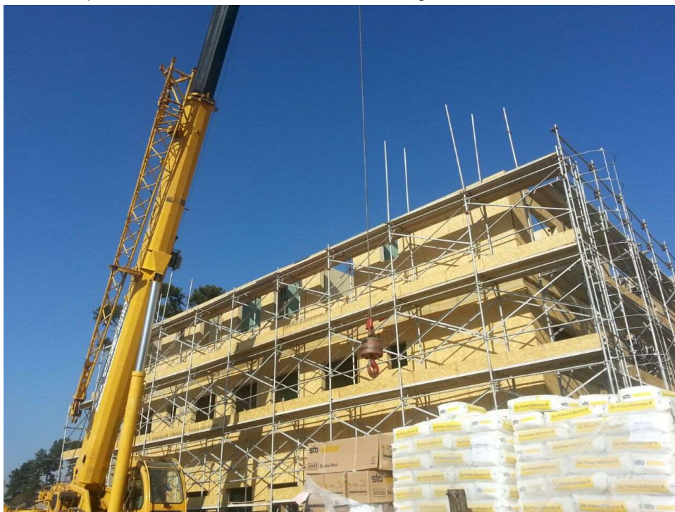
Figura 4 – Primeiro prédio no Brasil construído com tecnologia verde em Araucária.
