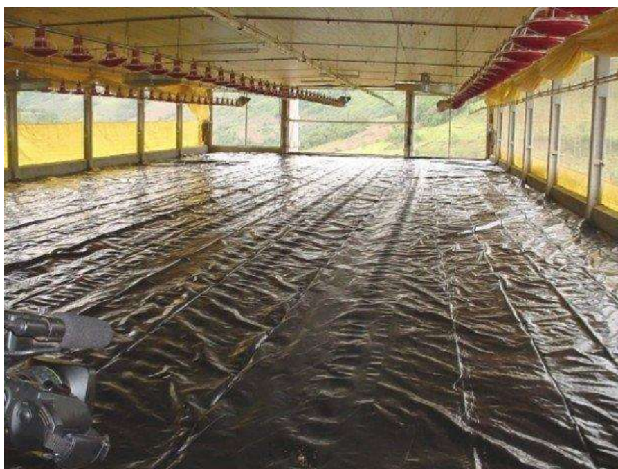
Figura 30 – Aplicação de lona plástica (filme de polietileno)
