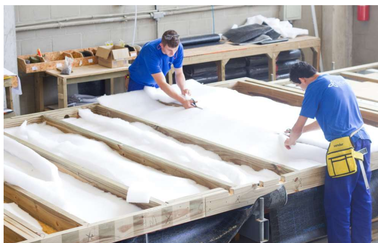
Figura 33 – Isolamento das paredes com lã de PET
